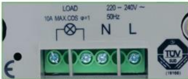
Bornas para la conexión del cableado.
